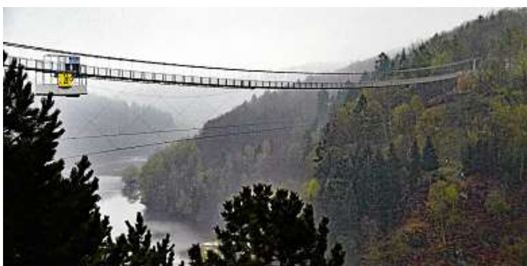
Die Weltrekordbrücke an der Rappbode-Talsperre im Harz ist fertiggestellt. Inmitten des Harz spannt sich nun die sogenannte Titan RT mit über 400 Metern über das Tal. Die genaue Länge wollen die Bauherren erst bei der offiziellen Eröffnung am Sonntag verraten. Foto: Peter Cott
